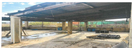
ZONA TRASERA AFECTADA POR LA CESIÓN Y EL RETRANQUEO.
